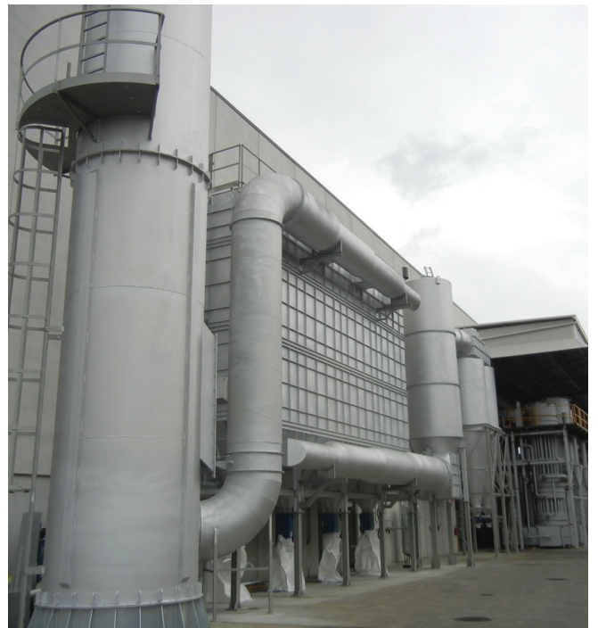
Sistema de aspiración y filtración de humos de hornos de fundición de aluminio con tratamiento químico de los humos en el reactor y sistema de dosificación y almacenamiento de reactivos - Italia
