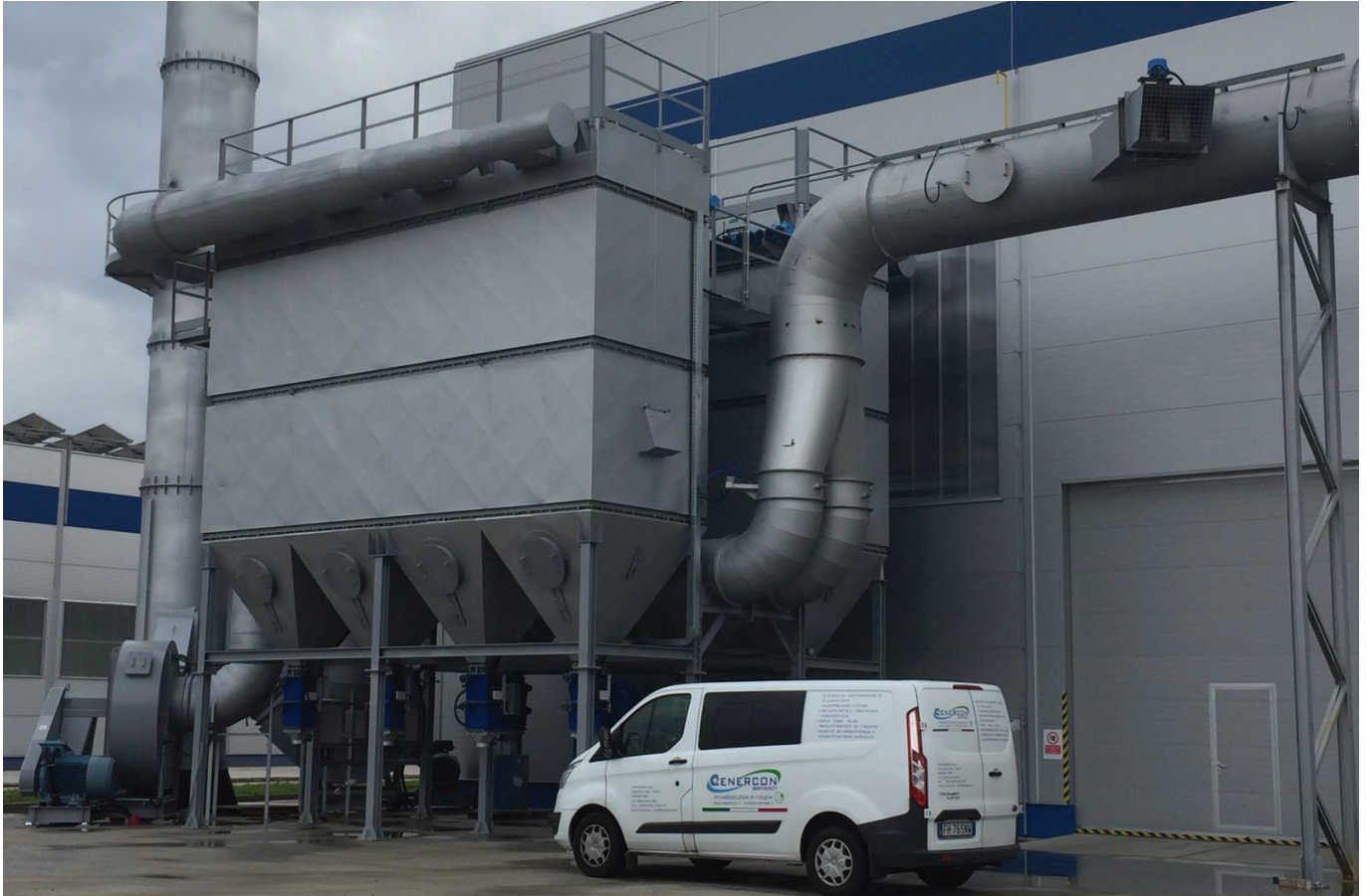
Sistema de aspiración y filtración de 85.000 m 3 /h para el tratamiento de humos de hornos de fundición de aluminio - Eslovaquia
