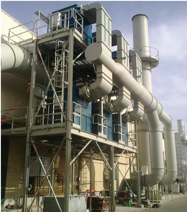
Sistema de aspiración y filtración centralizada ENERPROG en 6 módulos dedicado a 4 inyectoras de gran tonelaje – Iran
