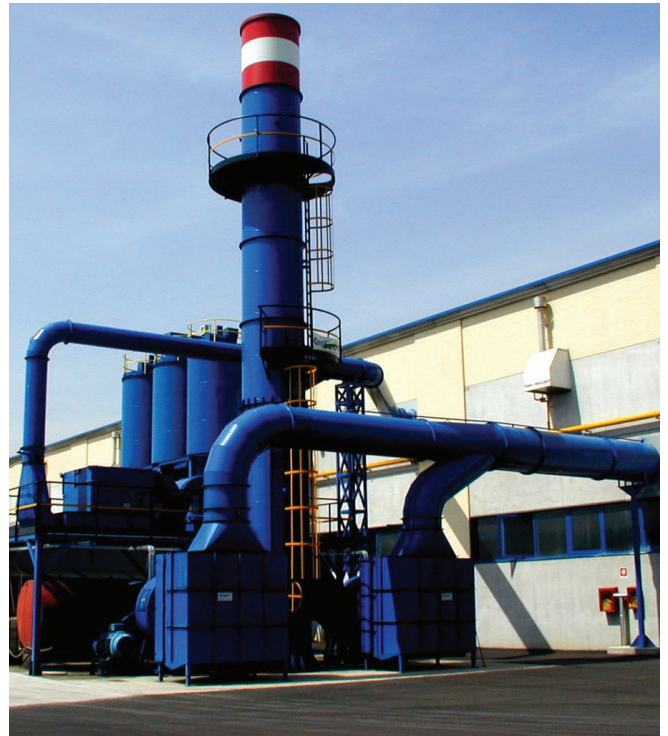
Sistema de aspiración y filtración centralizada ENERPROG . Italia
