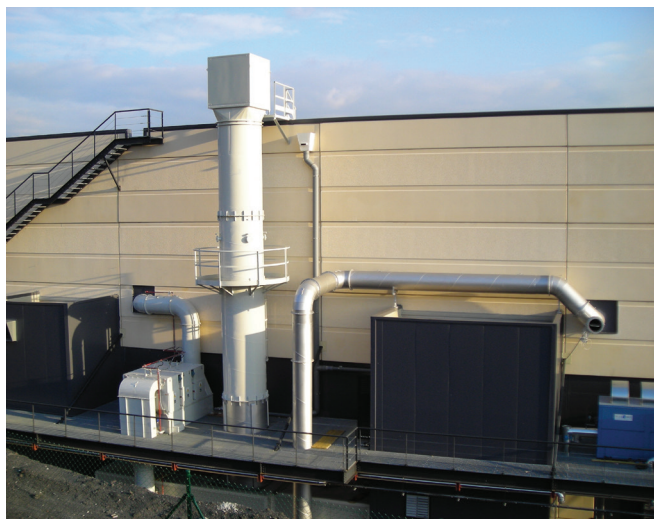
■ Sistema de aspiración y filtración centralizada ENERPROG en 2 módulos para un caudal total aspirado de 32.000 m³/h dedicado a 4 inyectoras - España
