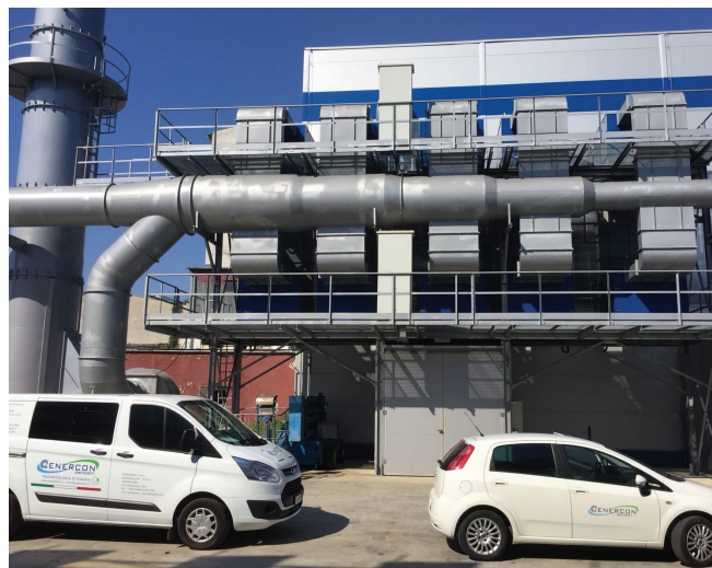
■ Sistema de aspiración y filtración centralizada ENERPROG en 10 módulos para un caudal total de 150.000 m³/h de aspiración para 19 inyectoras - Eslovaquia
