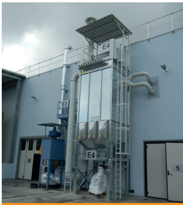
Impianto di aspirazione e filtrazione polveri alluminio da smerigliatura manuale – Italia
