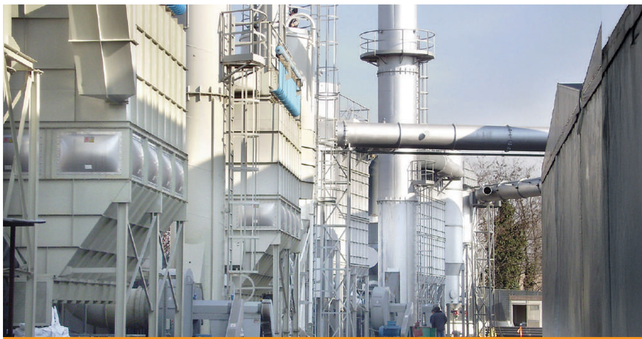
■ Impianti tecnologici di aspirazione e filtrazione fumi da forni fusori e polveri da lavorazioni meccaniche a servizio di raffineria di alluminio – Italia
