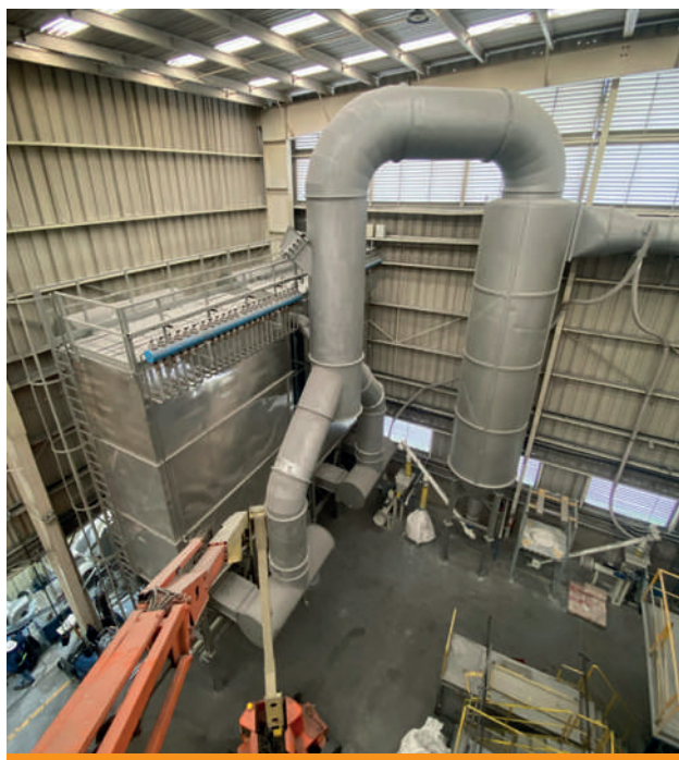
Impianto di aspirazione e filtrazione fumi da n.3 forni fusori alluminio, n.1 essiccatore e n.2 postazioni degasaggio per portata di 100.000 m 3 /h completo di inertizzazione inquinanti acidi – Messico
