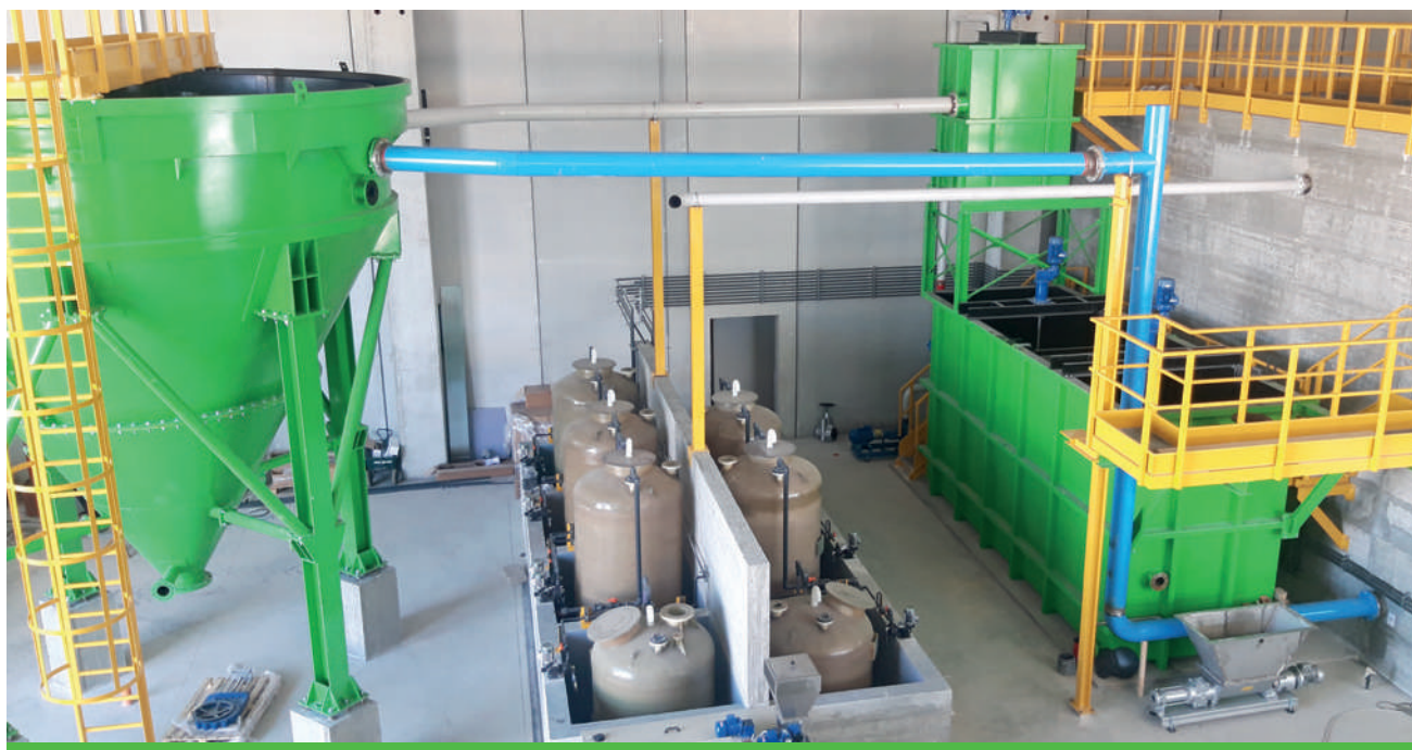
Impianto trattamento terra (soil washing), realizzazione carpenterie, piping ed installazione – Italia
