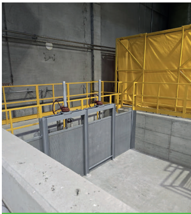
■ Sistema di paratoie fisse e mobili per separazione limo fisse e mobili in lamiera forata su vasca in cemento, progettate per trattenere i solidi da reflui fangosi stradali e consentire il deflusso controllato del liquido verso lo stoccaggio – Italia
